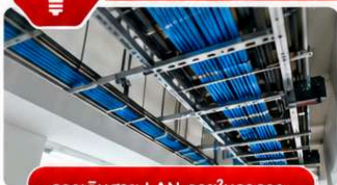
การเดินสาย LAN ภายในอาคาร
